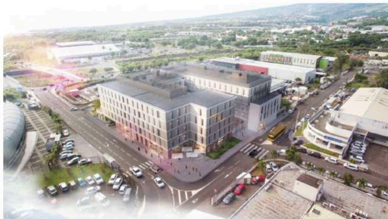
Le Cour Kerveguen, le nouvel immeuble de bureaux et de commerces au coeur de la ZAC du Chaudron
