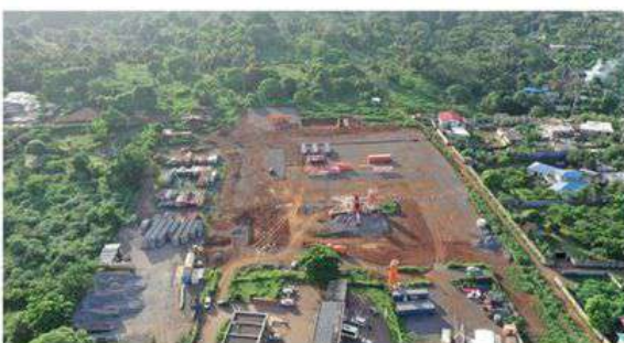
Seule infrastructure d'envergure en cours de construction aujourd'hui : le futur centre commercial de 8 000 m 2 à Combani (photo DR).
