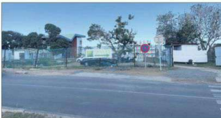
Situé face au parking des loueurs de voitures, les abords et les espaces verts du nouvel établissement restent à terminer.
