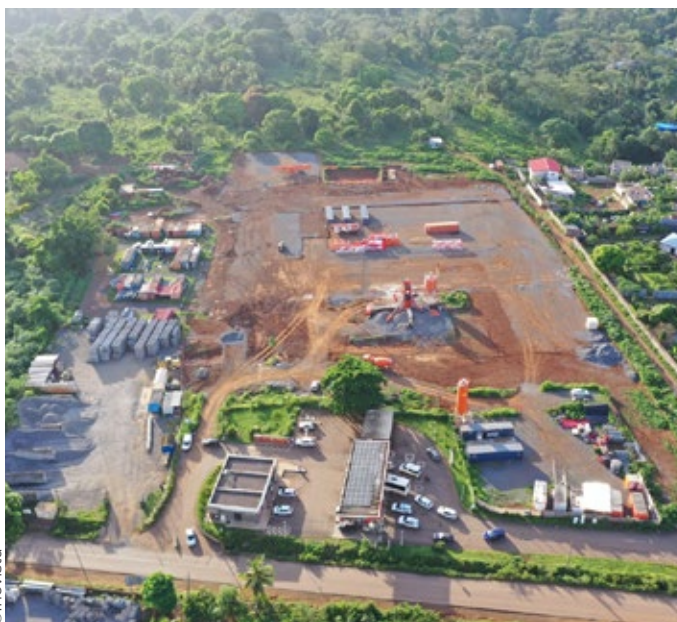
La zone d'activités économiques de Combani, en cours d'aménagement.
